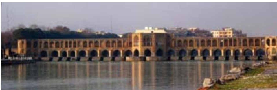
Puente Khaju, Isfahan, Irán
