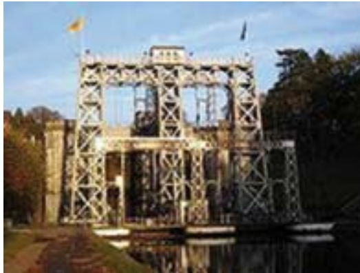
Elevador Núm. 2, Los cuatro elevadores del Canal du Centre (Uso de la fotografía autorizado por Wikimedia Commons)
